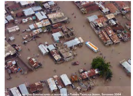
LES MAISONS DE GONAÏVES APRÈS LE PASSAGE DE LA TEMPÊTE TROPICALE JEANNE, SEPTEMBRE 2004
